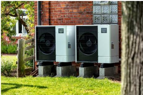
(2790): Zum Einsatz kommen zwei kompakte Ecodan Luft/Wasser-Wärmepumpen des Herstellers Mitsubishi Electric, die als Kaskade im Außenbereich installiert worden sind.
