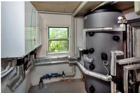
(2684): Für jede Außeneinheit steht im Technikraum ein Hydromodul zur Verfügung. Darüber hinaus sorgt das 1.000-Liter Kombispeichersystem für die Erwärmung des Trinkwarmwassers und des Heizungswassers.
